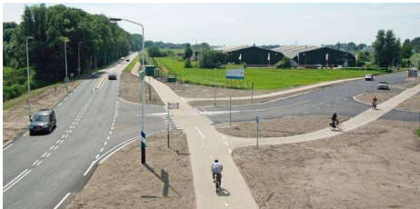
Fietspaden van lichtreflecterend asfalt (beeld: Dura Vermeer)
