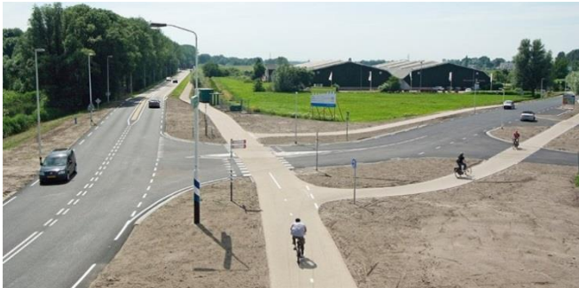
Fietspaden van lichtreflecterend asfalt (beeld: Dura Vermeer)
