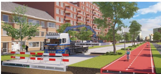
Fietspad van gerecycled plastic in Zwolle (beeld: Plastic Road)
