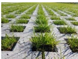
Parkeerterrein met gras-betonelementen
